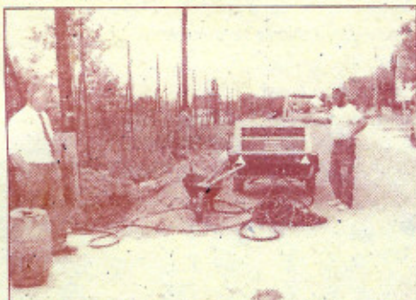
Épül a szennyvízcsatorna
